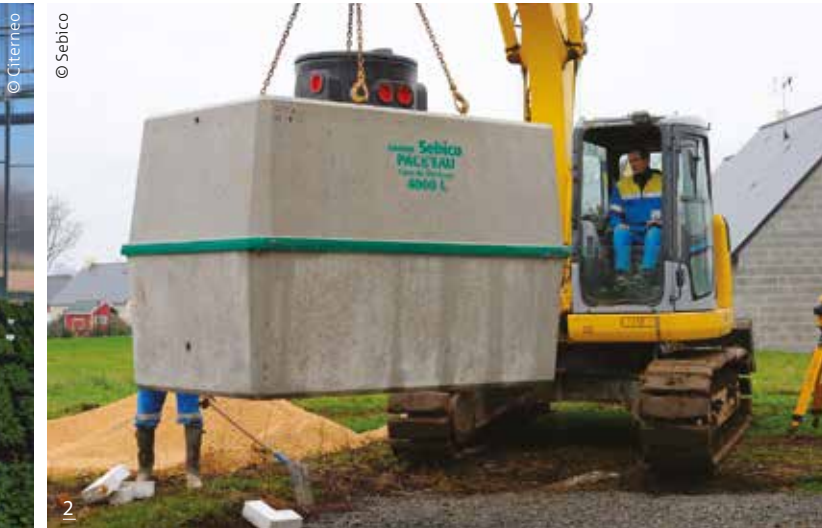
1/ Solutions économiques pour récupérer les eaux de pluie, sans engager des travaux : les citernes souples. Proposées par Citerneo, elles s'installent partout et rapidement. Capacité de stockage : entre 2 et 3 000 m 3 . 2/ Exemple d'une cuve en béton (modèle de la gamme Pack'eau de Sebico) dotée d'un système de filtration au sommet.
