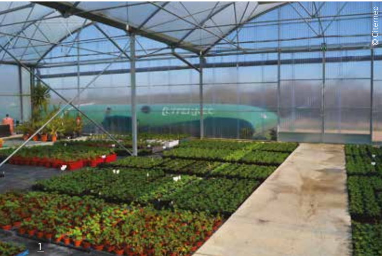
1/ Solutions économiques pour récupérer les eaux de pluie, sans engager des travaux : les citernes souples. Proposées par Citerneo, elles s'installent partout et rapidement. Capacité de stockage : entre 2 et 3 000 m 3 . 2/ Exemple d'une cuve en béton (modèle de la gamme Pack'eau de Sebico) dotée d'un système de filtration au sommet.
